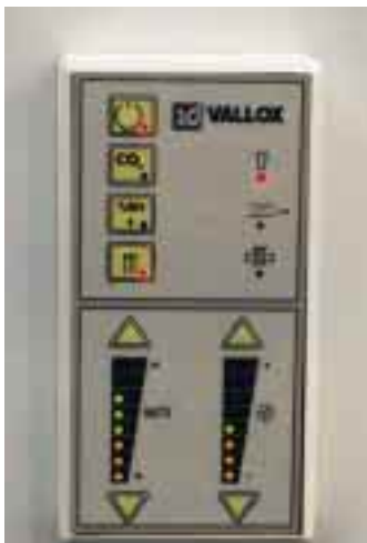
Personen- und feuchteabhängige Regelung von Wohnungs-lüftungen durch Änderung der Ventilator-drehzahl
