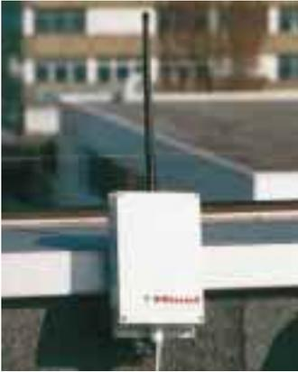
**Minomat collect: Im Umkreis von 500 m werden alle Verbrauchswerte per Funk ausgelesen, zwischengespeichert und per Modem an das Minol-Rechenzentrum gesendet**
