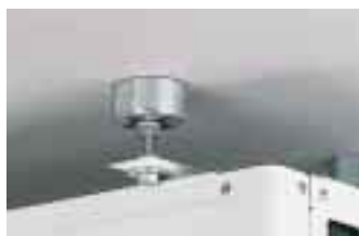
Decken- oder wandhängende Lärmerzeuger lassen sich mit dem Phonolytknopf von Müpro ebenso schallentkoppeln wie bodenstehende
