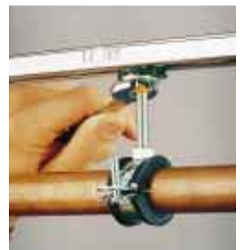
Zeitsparend ist die Montage von Rohrleitungen, wenn man die Schellen mit dem Hammerfix an Schienen befestigt
