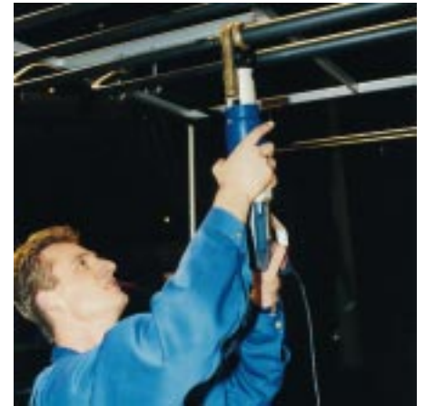
Die Überraschung des Jahres war der Kunststoffitting für die Verlegung von Verbundrohren, der mittlerweile von sechs Systemherstellern angeboten wird (Bild: Geberit)
