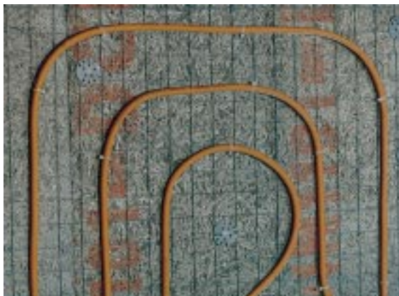
Bei der Installation der Wandheizung in Wohnküche und Schlafzimmer erwies sich eine einfache Mehrschichtverbundplatte an der Wand als ausreichend
