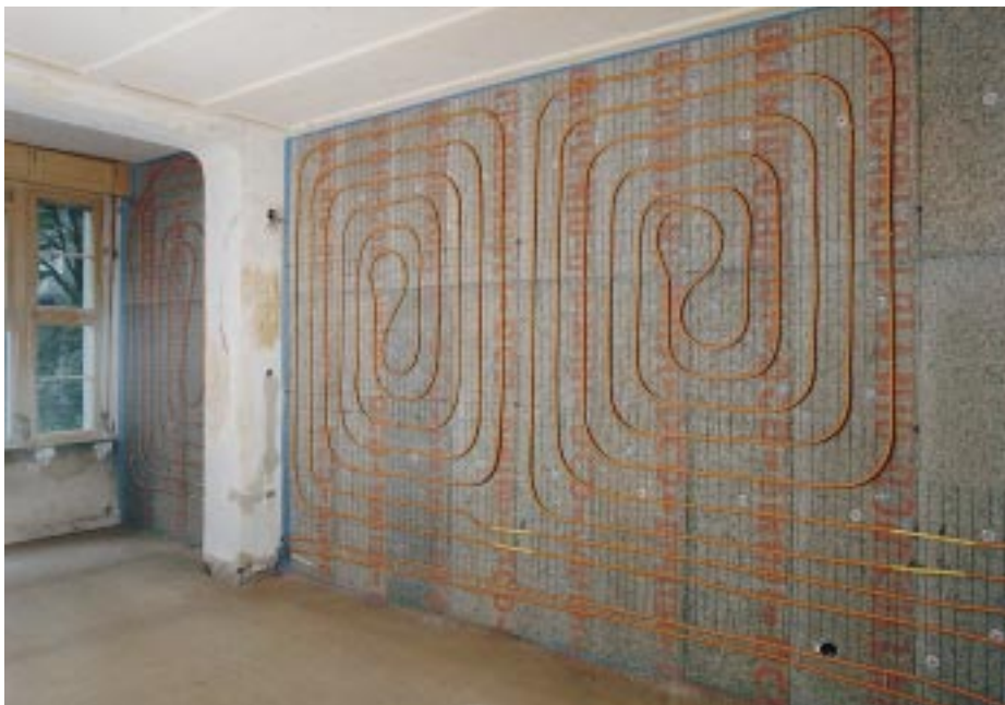
Auf einem AKS-Gitter wurden die Kupferrohre der Dimension 12 x 0,7 mm mit Kabelbinder befestigt und dieses an die Wand geschraubt. Abschließend erfolgte der Putzauftrag in zwei Lagen
