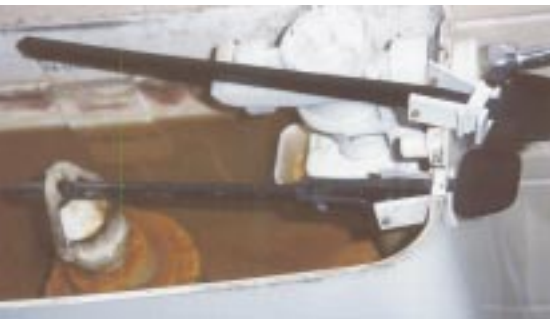
Für Spül-Stopp geeignetes Ersatzteil im Vergleich zum eingebauten Hebel, der bei jeder Betätigung 9 l Wasser abgibt
