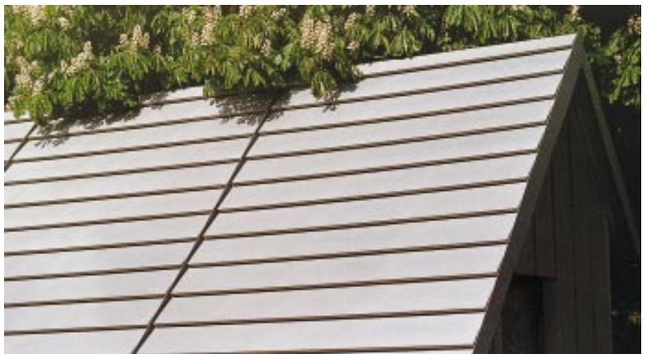
Die charakteristische, stufenförmige Struktur des „Quick Step“-Treppendaches ergibt eine markante horizontale Gliederung der Metaldachfläche
