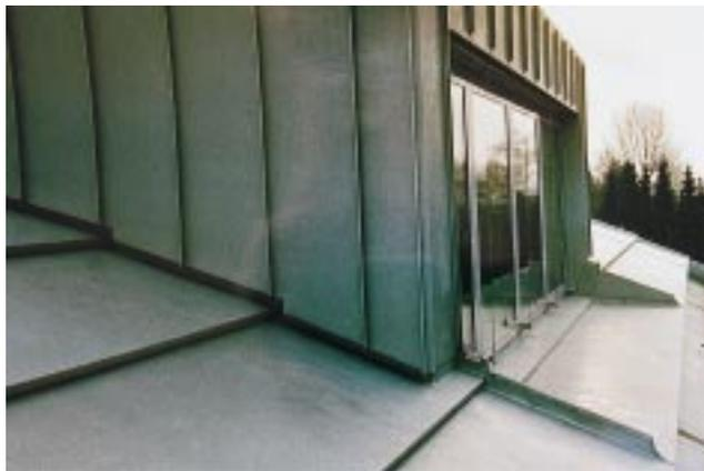
Dachneigung stehen zwei Ausführungen dieses Eindeckrahmens zur Verfügung; einer für den Neigungsbereich von 10 bis 35°, der andere für 36 bis 60°. Hierbei bildet der fachgerecht montierte Eindeckrahmen mit dem „Quick Step“-Treppendach eine harmonische Einheit.
