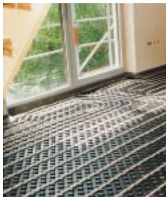
naues Zusammenfügen der einzelnen Elemente. Zuschnitte werden mit üblichen Cuttern ausgeführt. Als einlagige Verlegung ist der Typ 35/32 für Decken gegen gleichartig beheizte Räume vorgesehen, in Verbindung mit Zusatzdämmstoffen kommt der Typ 20 zum Einsatz. Normgerechte Abstände sind durch das Noppenraster von 50 mm gewährleistet. Geeignet ist das Dämmsystem für die Verwendung von FF-thermo-Difustop-Rohre in der Dimension 14 x 2.
