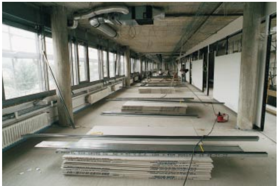
Auf insgesamt 890 m 2 Neubaufäche wurde das SST-Vari-P-System verlegt
