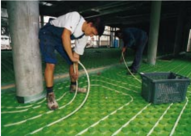
Für die schnelle Montage der Rohre sorgt das einfache Eindrücken zwischen den Haltenoppen auf der Systemplatte
