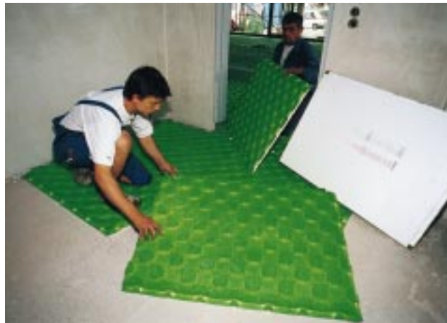
Durch die integrierten Haltenoppen erzielen die Grundlelementplatten des SST-Vari-P-Systems eine exakte Fixierung der Rohre
