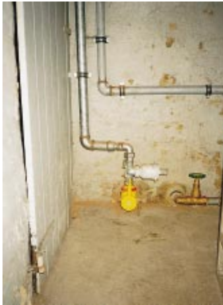
Ist der Hausdruckregler mit Mangelsicherung ausgestattet, soll dieser möglichst unmittelbar auf der HAE montiert werden
