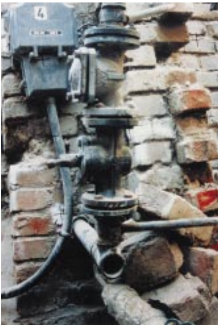
Auslöser des Unglücks war der Gas-Hausanschluß DN 40, von dem der Stopfen des Reinigungs-T-Stückes entfernt worden war [1]
