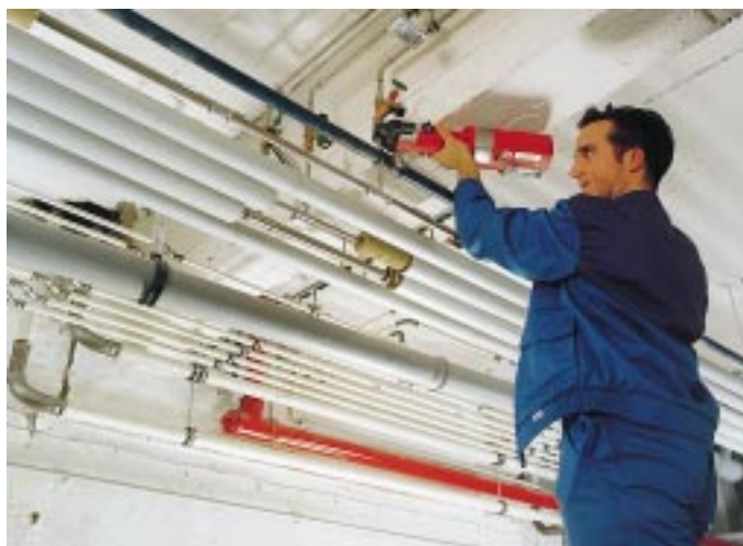
Die Rohrverbindungen halten Drücken bis 16 bar und Temperaturen bis 120 °C stand
