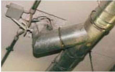
*Nach Einbau der HDE-Dachabläufe erfolgt die Verlegung einer Begleitheizung und die Wärmedämmung der Schleppleitungen*
