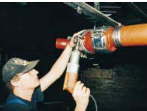
Vom Scherenhubwagen aus erfolgte die Montage der SML-Rohre mit längskraftschlüssigen CE-Verbindern und Halberg-Krallen
