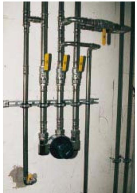
*Die Leitungen der Trinkwasserversorgung für die sanitären Einrichtungen sind aus Edelstahlrohr, verpreßt, hergestellt worden*
