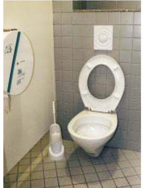
*Nach Anschluß an Zu- und Abfluß sowie Bepflankung und Verfließung kamen aus Gründen schnellerer und sicherer Bodenpflege wandhängende Klosettbecken zur Verwendung*
