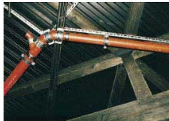
Für die HDE-Anlage der Messehalle 1 wurden über 1000 m SML-Rohr in den Nennweiten DN 40 bis DN 150 benötigt
