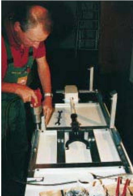
*Für die sanitären Einrichtungsgegenstände wurden auf der Baustelle konfektionierte Zako-VWI-Elemente verwendet...*
