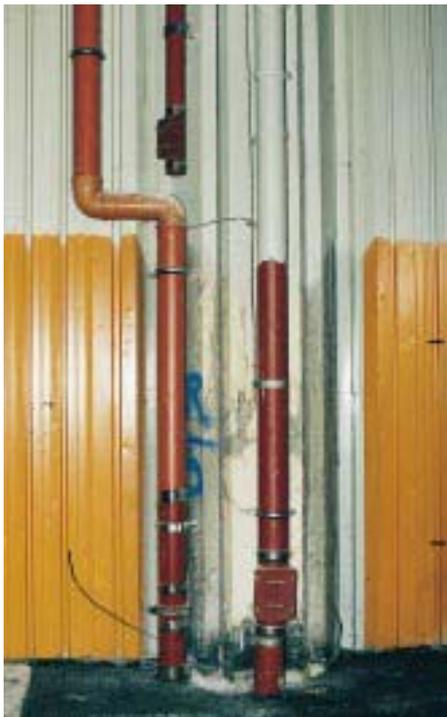
*Aufgrund der engen Montagefristen konnte die HDE-Leitung (M.) zu diesem Zeitpunkt noch nicht mit der Grundleitung verbunden werden. Statt dessen ist an diese vorübergehend die Falleitung der bisherigen Abläufe (I.) angeschlossen*
