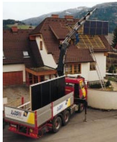
sich sowohl Klein- als auch Großflächen realisieren. Die Module werden mit dem Kranwagen angeliefert und vom Sonnenkraft-Team aufs Dach gehievt und dort befestigt. Die Einbindung in die Solaranlage ist dann Aufgabe des Installateurs.
