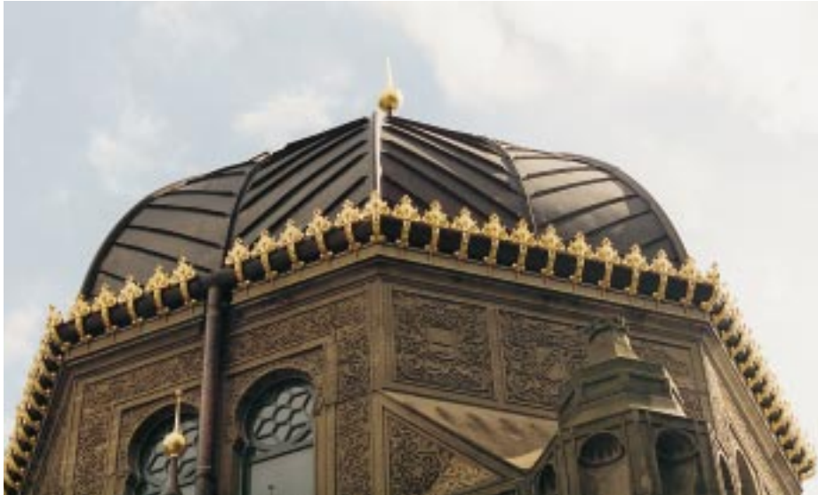
Neben den fischgrätenartigen Kupferscharen der Dachbekleidung ziehen die vergoldeten Rinnehalterverzierungen die Blicke auf sich
