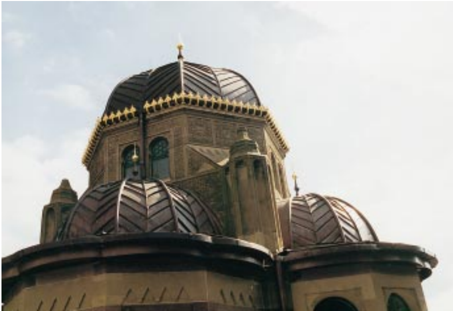
Übergang vom viereckigen Grundriß des Hauptteils mit seinen Anbauten auf den achteckigen Turm mit seinem achthflächigen „Klostergewölbe“
