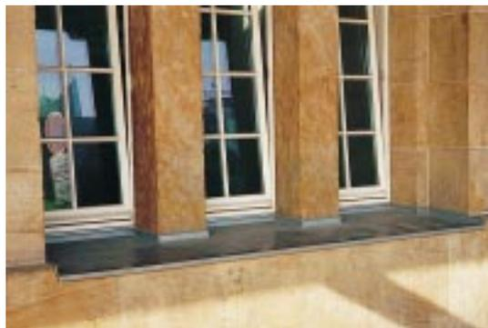
*Detail einer Dreifachfensterbank; Pfeilerausparungen und Anschlüsse sind sorgfältig gearbeitet*
