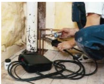
*Das Smart-Lötssystem von Alarm Virax ist in zwei Varianaten erhältlich: Compact dient zum Weichlöten von Cu-Rohren bis 22 mm Durchmesser, Combi bis 54 mm sowie zum Auftauen*
