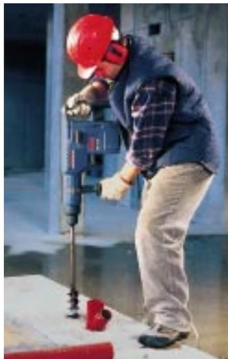
**Mit dem neuen Bohrhammer GBH 11 DE wird in 60 Sekunden ein 55 mm-Durchbruchbohrer 110 mm tief in Beton getrieben**
