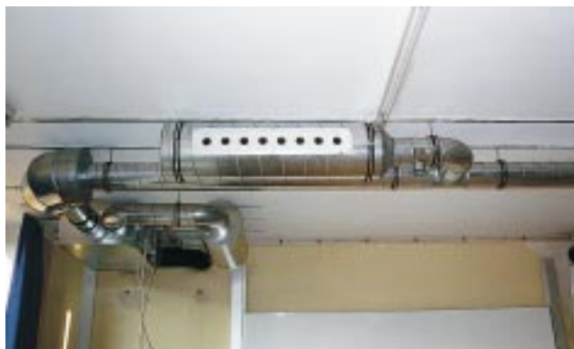
Das Weitwurfgitter Typ WGA mit Ausblasrichtung längs in den Raum
