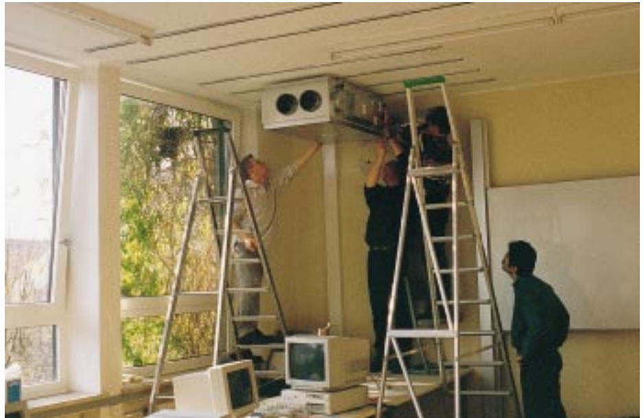
Schüler bei der Montage eines Lüftungsgerätes für die kontrollierte Wohnraumlüftung im Datenverarbeitungsraum der Techniker-Schule Würzburg
