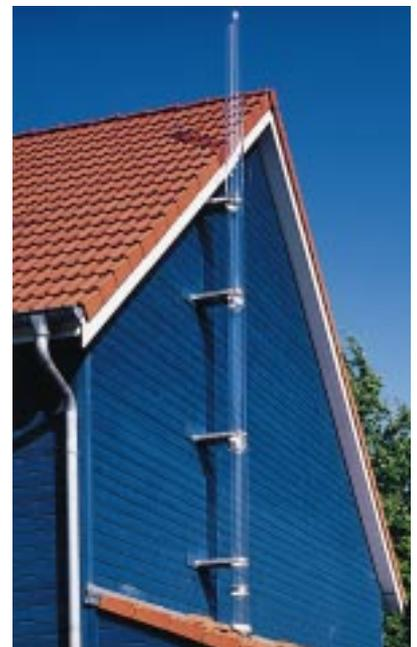
len Bauausstellung (IBA) diese Bauart verwirklicht. In der neuen Emscher Park-Siedlung versorgt beispielsweise ein 200-kW-Brennwertkessel 30 Wohneinheiten mit Wärme. Die Abführung der Abgase erfolgt über eine „Recusist“-Anlage mit einem Durchmesser von 180 mm und einer Höhe von 9,0 m. Der gläserne Schornstein ließ sich, bedingt durch die Transparenz des Werkstoffs, nahtlos in die Siedlungsarchitektur integrieren.
