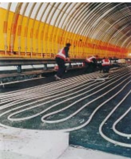
Rund vier Kilometer VPE-Rohr vergossen die Bauarbeiter in den Beton unterhalb der Straßendecke
