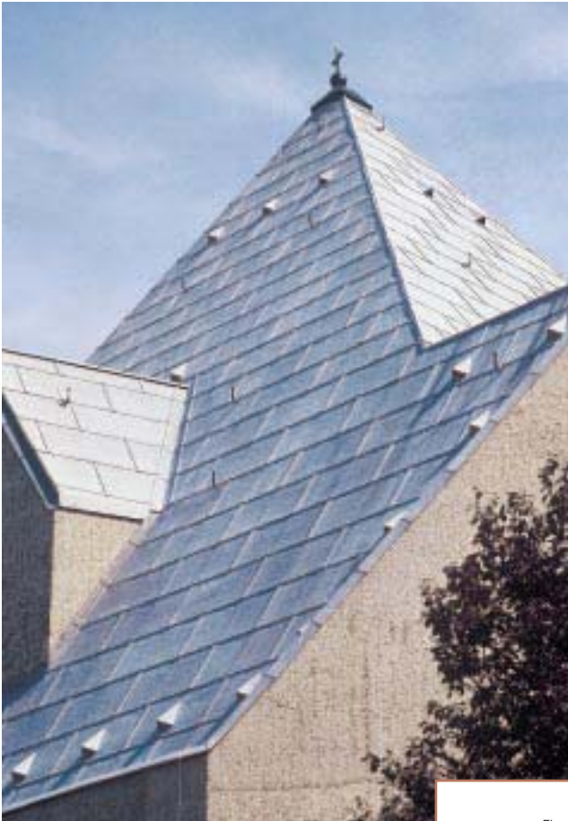
Teilansicht des Daches mit Ortgangbereich, Dachkehle und Wandanschluß in Bleiblech
