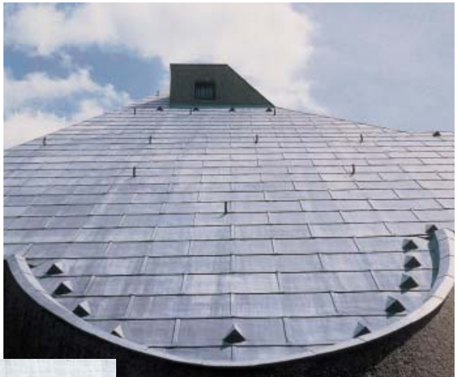
Konturierung einer im Halbverband mit Liegefalzverbindung gedeckten Dachfläche
