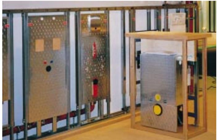
*Die von Ferroplast präsentierte VWI-Serie Ferrobloc wurde um das „kompatible“ Urinal-Element (M.), die Serie Ferromount um ein WC-Element mit der Einbauhöhe 820 mm und Betätigung des Spülkastens von oben oder von vorn (r.) erweitert*
