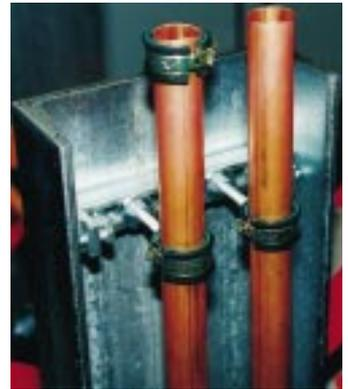
Die in den Klemmschenkeln der Stahlträger-Nuß angeordneten Klemmschrauben pressen sich mit ihren Spitzen beim Anziehen in das Stahlprofil und bieten so Halt für die Halter der Rohrleitungen (Müpro)
