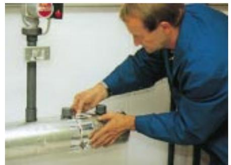
Die Querstöße der Dämmschalen von Steinbacher vom Typ Steinonorm 320 für sichtbar verlegte Rohre werden mit Klebeband abgedeckt
