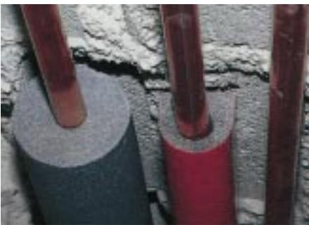
*Platzsparende Verlegung von warm- und kaltgehenden Rohrleitungen verspricht Steinbacher mit dem exzentrischen Dämmblock vom Typ Steinoflex 470*
