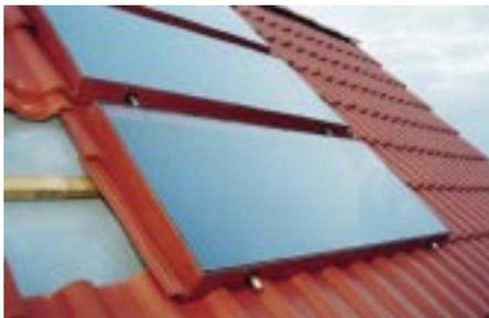
Die Cuadro-Solardachziegel-Anlage von Alligator Sunshine kann bis zu 20 Solardachziegel-Einheiten umfassen
