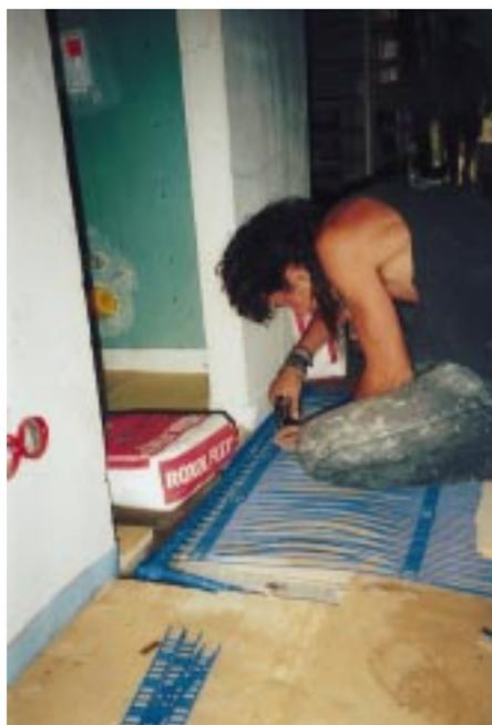
Bild 1 Befestigen der Heizmatten auf dem Fußboden
