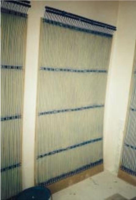
**Bild 5 Heizmatten auf Gipskartonplatten ge-
