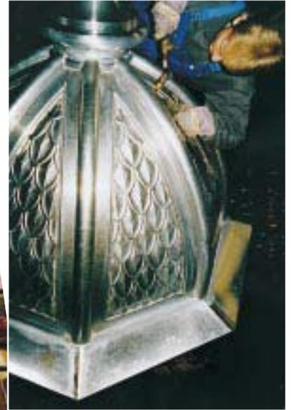
*Aufgrund moderner Herstellungsverfahren konnte die Zinkbekleidung der Haube des Hauptturmaufsatzes aus weniger Stücken zusammengesetzt werden als das Original*
