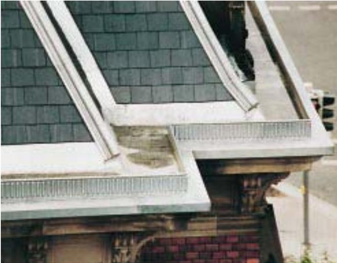
*Traufdetail des Mansarddaches mit Klempnerarbeiten im Bereich von Kehlen, Einhangblechen, Gratabdeckungen und Gesimsabdeckung. Das Attikablech ist mittels Stahlwerkzeugen modelliert worden*
