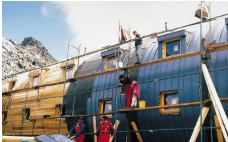
Keine Aluminiumschar ist über 9 m lang. Die Querstöße wurden im stark geneigten Bereich der Dachfläche als einfache Liegefalze ausgeführt
