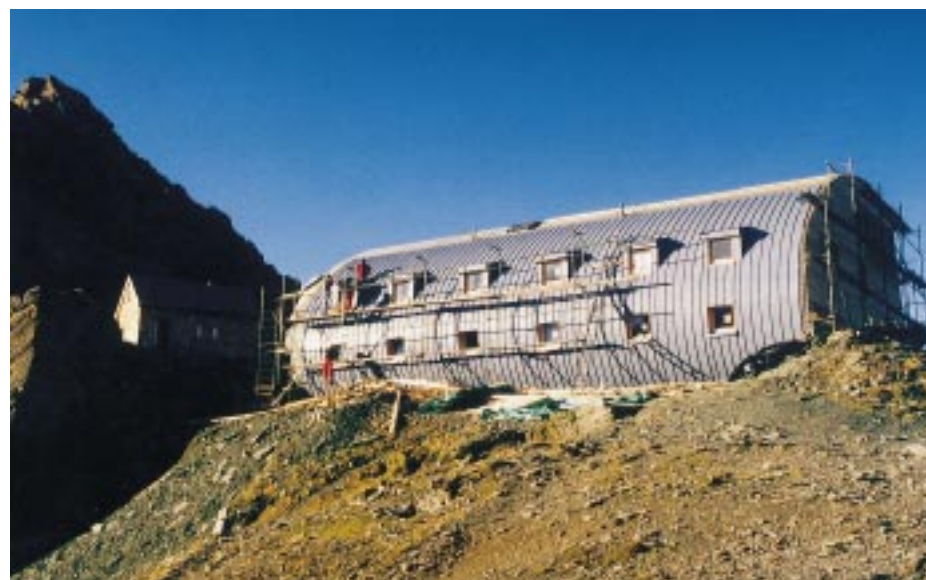
Das nach Norden weisende tonnenförmige Dach, dessen Rundung bis auf den Boden reicht und dem Wind relativ wenig Widerstand entgegengesetzt
