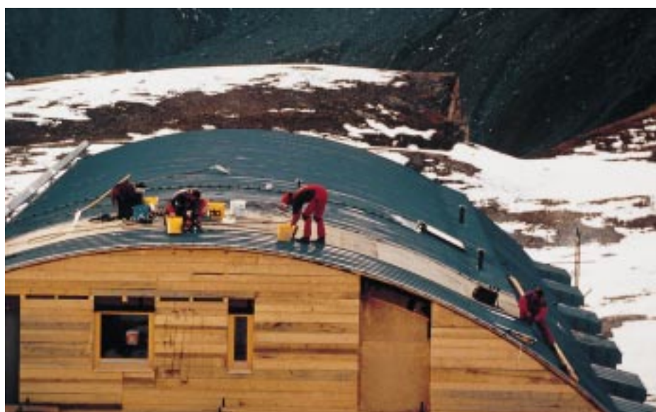
Der größte Teil der Dachfläche ist bereits mit Aluminiumscharen bekleidet, ebenso die Dachgauben
