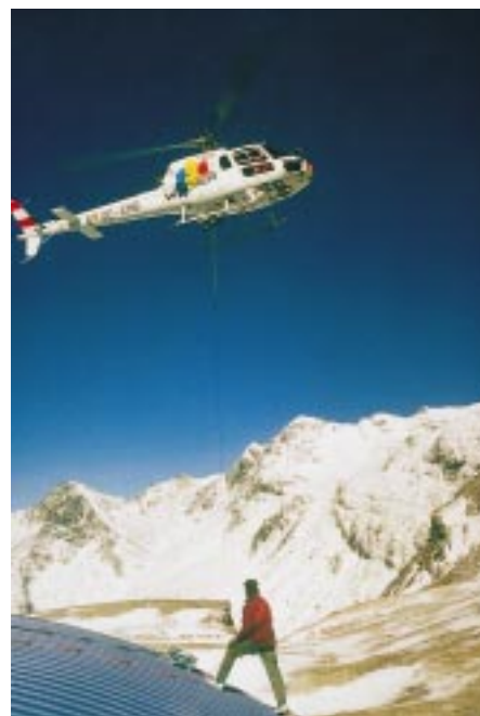
Ohne Transporthubschrauber lief beim Neubau der Stüdlhütte fast nichts. Unser Bild zeigt einen angeseilten Spengler mit einer Doppelstehfalzmaschine auf einer fast fertigen Dachteilfläche
