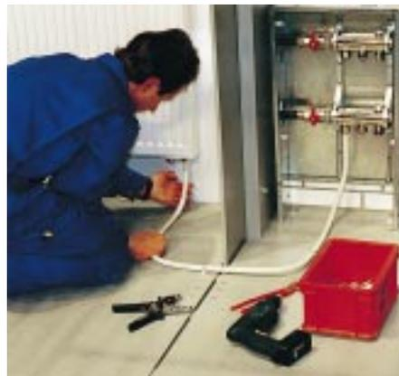
*Mit Meplatherm schuf Geberit ein Verbundrohr für die Heizkörperanbindung. Zur Vermeidung von Verwechslungen ist die Außenschicht weiß eingefärbt*
