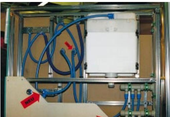
Das aufgeschnittene Vorwandinstallations-Modell zeigt links und oben die Anschlußadapter aus PE-X, rechts unten die Übergangsadapter aus PE und PP aus dem Tersia-Programm von Rafeld, die beide per Heizelement mit PE-X- und PP-Rohren verschweißt wurden
