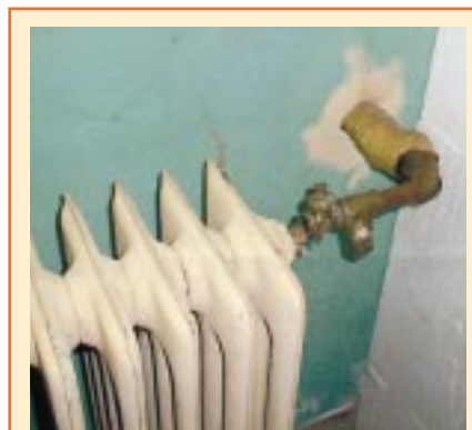
Eine ganz besondere Art von Heizkörperventil schickte uns Jürgen Ziebeck aus 21635 Jork für die Rubrik „Besonderes und Geniales“. Die Montage erfolgte durch einen Liebhaber absperrender Radiatorverschraubungen. Manchmal kann man einfach nur die Hände über dem Kopf zusammenschlagen.
