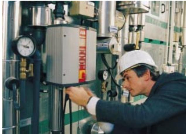
Die Module der Energiebus-Technik übernehmen sowohl Energie- als auch Regelfunktionen und werden direkt in die Anlage montiert
