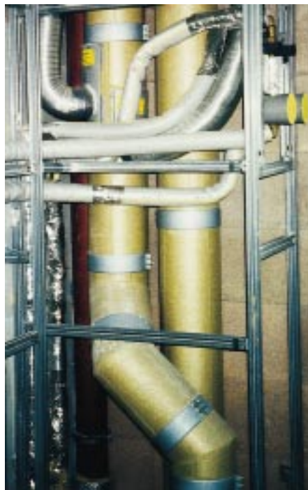
Umfahrungen der Lüftungs- und der Wasserleitungsrohre waren aufgrund der verwendeten Systeme kein Problem für die Installateure
