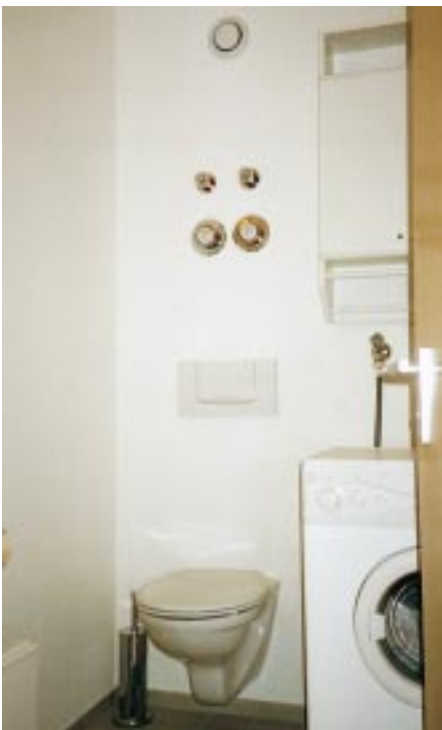
... Das gleiche Modul beplankt und ausgestattet mit wandhängendem WC, Wasserzählern und Waschmaschinenanschluß sowie dem Lüftungsventil
