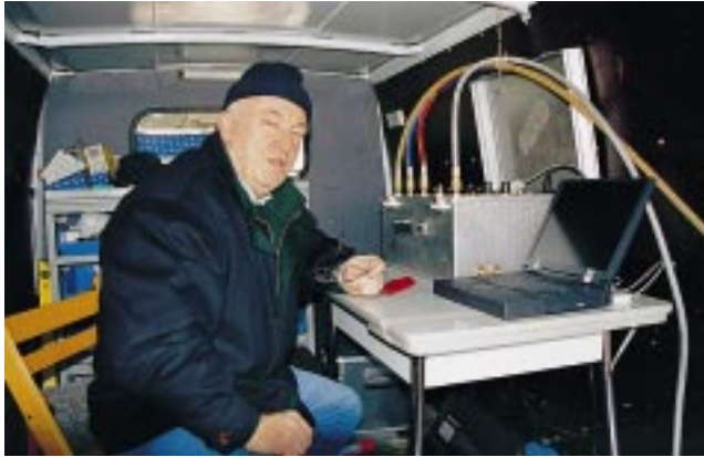
Die Dichtheit der Abwasserleitung prüft Willi Haase im Werkstattwagen mit computergestützter Meßtechnik
