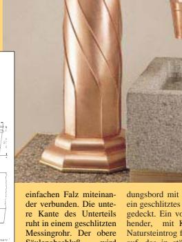
Säulenabschluß durch einen Kugelabschnitt aus Kupfer, 0,8 mm gebildet, der Verbin-
