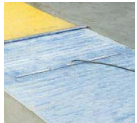
Bild 5 Vakuump-Teppich zur Entwässerung der Betonfläche
