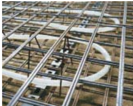
Bild 3 Stahlbeton mit Mattenbewehrung
