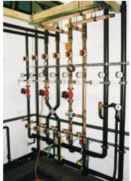
... und der Zentralheizungs- und Lüftungsbauer in den Montageboxen der Gewerbeakademie Donaueschingen
