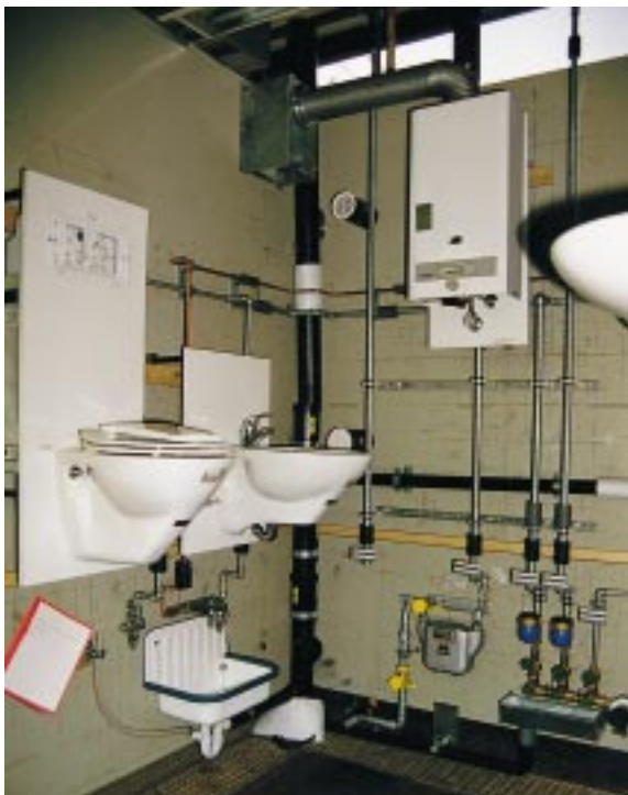
Ausschnitt aus der praktischen Prüfung (Teil I) der Gas- und Wasserinstallateure...
