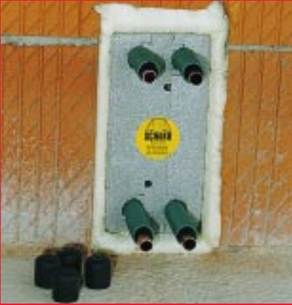
1. Montageschritt: Der Block wird mittels PUR-Schaum in die Wand eingebaut
