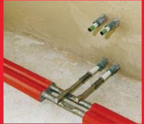
3. Montageschritt: Nach Anschluß von Vor- und Rücklaufleitungen kann die Wärmedämmung vervollständigt werden
