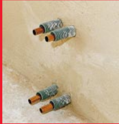
2. Montageschritt: Bei aufgesteckten (!) Schutzkappen erfolgte die Fertigstellung der Wandbekleidung
