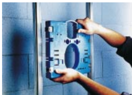
Per Cliptechnik lassen sich die Tragplatten an jeder Stelle des Tragwerks einsetzen und nachträglich bis zum Fixieren in der Höhe verschieben
