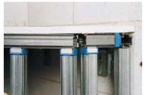
Die Stabverbinder sind ohne Werkzeug an jeder Stelle des Tragwerks einzusetzen
