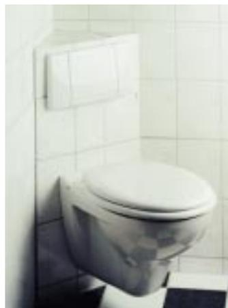
mm mit der Spül-Betätigung von vorn und Innenleben sowie Taste von Geberit lieferbar. Der sogenannte Stein kann direkt befließt werden, eine Beplankung erübrigt sich. Das Diagonalmaß beträgt in eingebautem Zustand 440 mm. Sontypen wie WC plus Bidet sowie Kombinationen mit anderen
