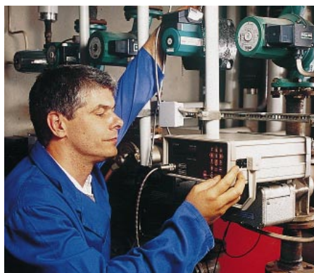
Hightec im Einsatz bei der Energieanalyse
