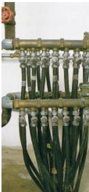
*Sammelschiene für Erdsonden, die zwischen 20 und 150 m tief in den Boden reichen [2]*
