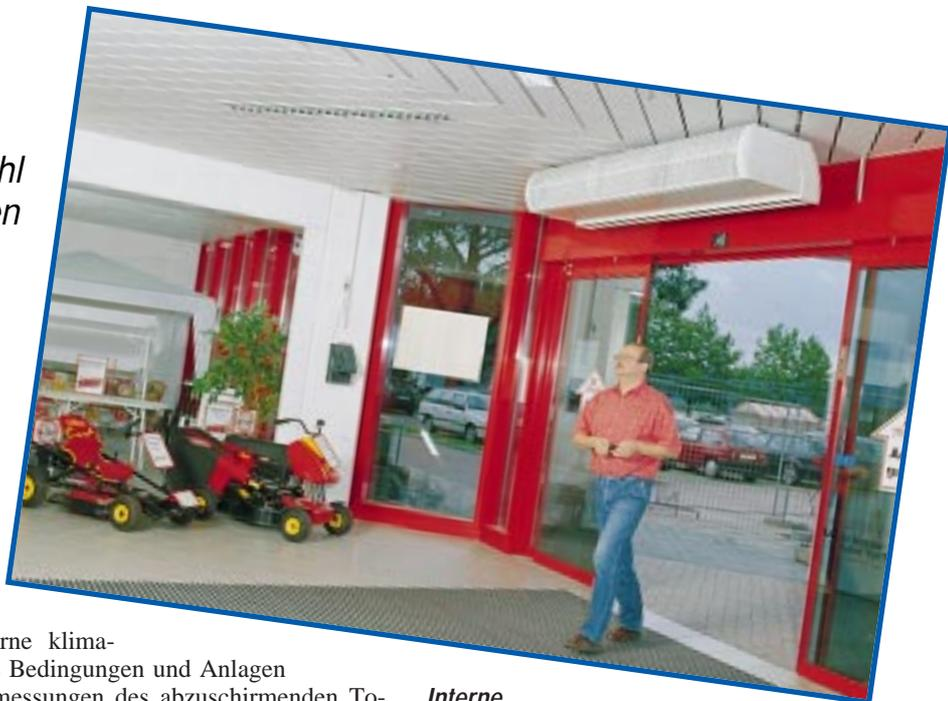
*Luftschleieranlagen schaffen zuverlässige und sichere Abschirmung vor Kalt- oder Warmlufteinfall an Toren oder Türen, die häufig geöffnet werden oder permanent geöffnet sind. Diese Luftschleier sparen durch ihre Funktion Heiz- oder Kühlenergie ein – vorausgesetzt, sie wurden richtig geplant und installiert. Nachfolgend werden die wichtigsten Grundlagen für Planung und Auslegung beschrieben.*
