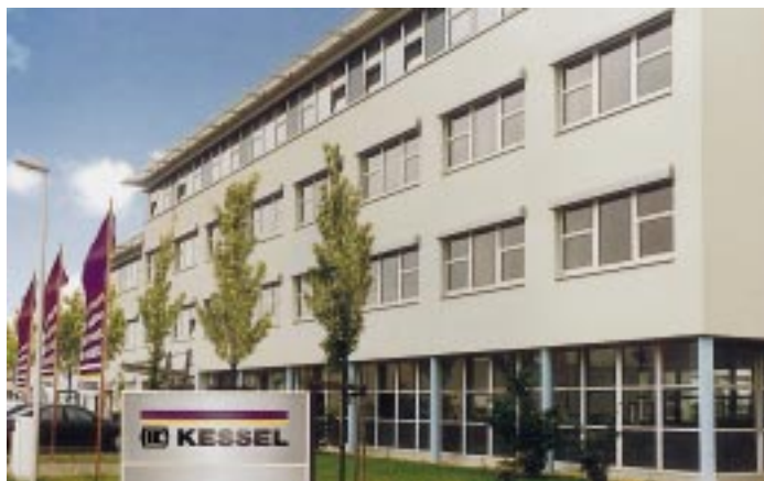
Kessel eröffnete ein neues Beratungszentrum „Alles für die Entwässerung“ in Leipzig/Dölzig
