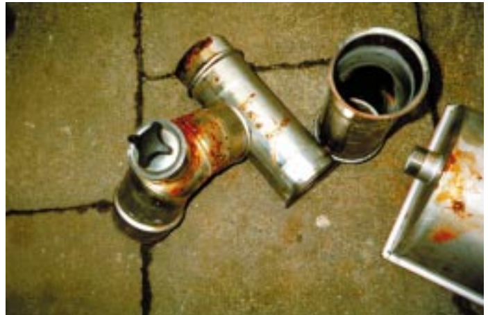
Bild 4 Perforationen an Edelstahlabgasleitungen
