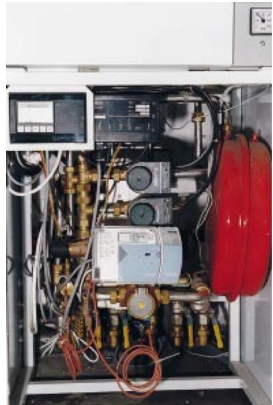
Auf Wunsch der Betreiber sind die Hausanschlußstationen eines dänischen Herstellers mit busfähigen Regelgeräten und Ultraschall-Wärmezählern von Landis & Staefa ausgestattet
