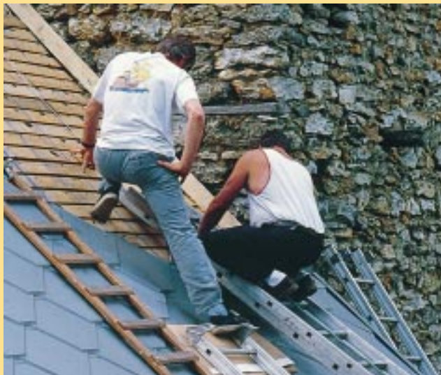
Spezielle Profile erleichtern z. B. den Anschluß des Daches an Wände oder Ortgänge
