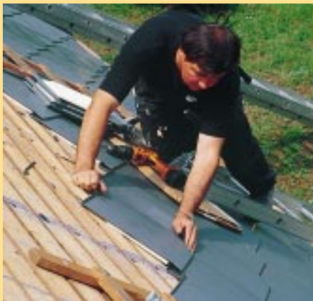
Nach Schnurschlägen für die Schindelachsen erfolgt das richtungsgenaue Verlegen der Schindeln
