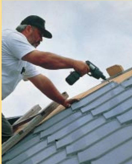
Mit drei Schrauben wird ein Dachelement jeweils auf der Schalung festgeschraubt
