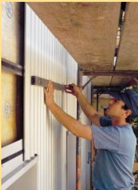
Die Trapezprofilplatten sind an die mit einem Dichtstreifen versehenen Fenstereinfassungen angepaßt . . .
