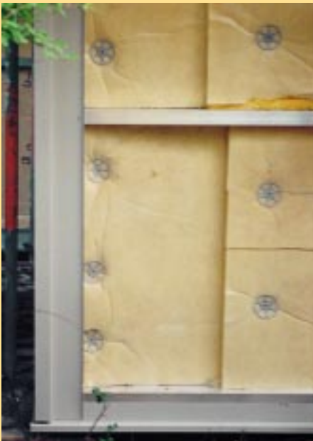
Bei den Details der Eckausbildung und des Sockelbereichs konnte auf die Erfahrung der vormaligen Sanierung zurückgegriffen werden
