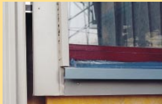
Fensteranschluß im Detail mit Laibung und Sohlbank
