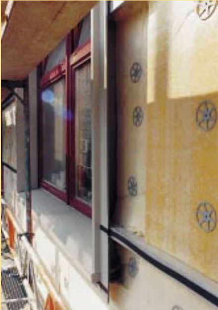
Erste Schritte der Sanierung: Anbringen von Unterkonstruktion, Fenstereinfassungen und Wärmedämmung
