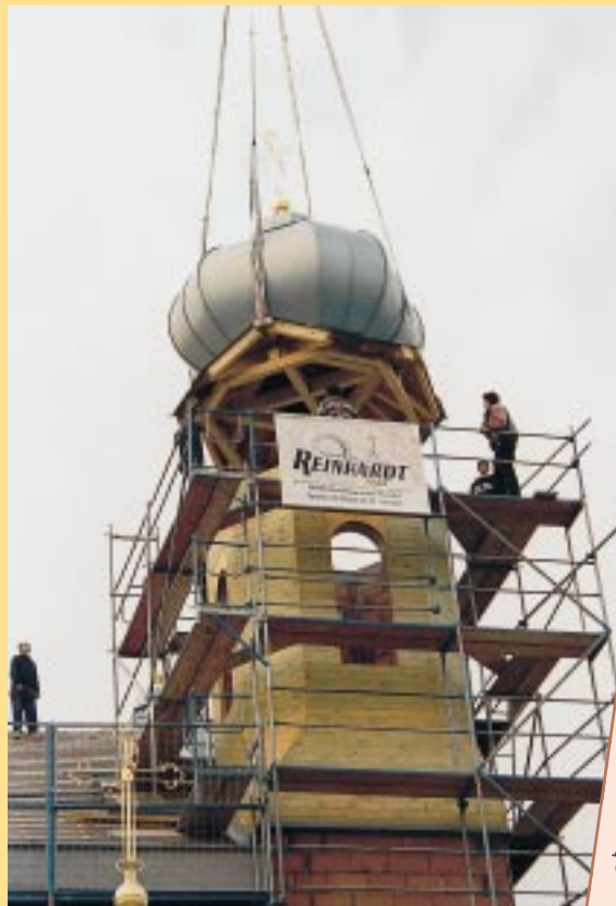
Die Hauben der Türme, auf dem Grund bekleidet und mit dem vergoldeten Kreuz versehen, wurden mit dem Kran auf den hölzernen Turmschaft gehievt
