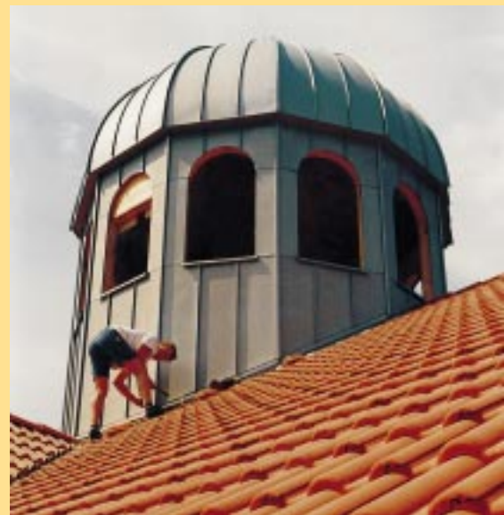
. . . die sich auch über die Fassadenflächen bis zum Dach weiterziehen. An den Graten sind sie in Leistenteknik verbunden, ansonsten als Winkelfalz ausgeführt
