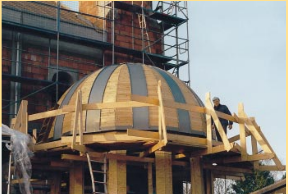
Die Kuppel über der Vierung hat einen zwölfeckigen Grundriß. Jede Seitenfläche ist mit drei Scharen bekleidet . . .
