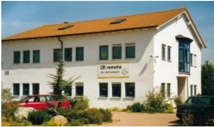
Die neue Remeha-Niederlassung steht in Bondorf
