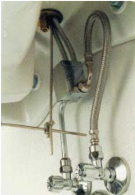
**Bild 3** Unterhalb eines Waschbeckens eingebauter Zirkulationsregler (bei kleinem Eckventilabstand)
