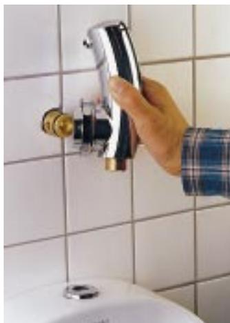
auch erheblich Wasser gespart werden. Gespült wird automatisch und zuverlässig nach Verlassen des Beckens.
