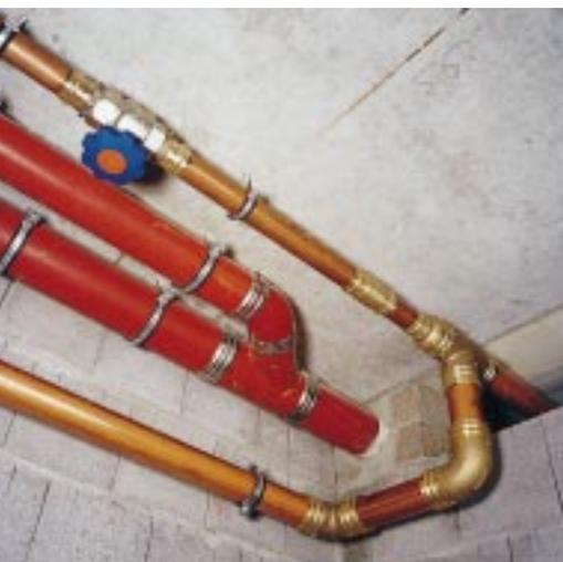
*Während für die Nennweiten ab DN 65 Preßketten erforderlich sind, benutzt man für die darunterliegenden Durchmesser Preßbacken*
