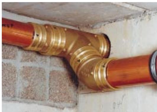
*Für die Feuerlöschanlage der 200 Wohneinheiten in der Bonner Mirecourtstraße wurden Kupferrohre mit Durchmessern DN 80 in Preßtechnik verlegt*
