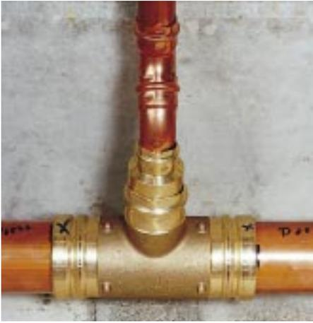
***Dichte und garantierte Verpressung durch Markierung der Einbautiefen sowie der Formstückmuffe nach dem Preßvorgang***
