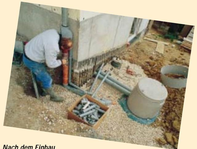
Nach dem Einbau können alle Anschlüsse des Regenwasserspeichers mit den entsprechenden Leitungen verbunden werden. Saugleitung, Pumpe und Überlauf werden installiert und der Zulauf an das Regenwassernetz angeschlossen. Danach kann die Grube bis über den Rand des Domschachts vollständig mit Erde aufgefüllt werden
