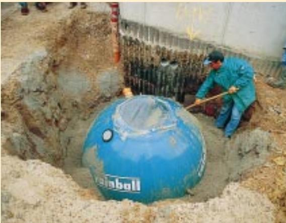
Mit einer Sandschicht wird in der Grube ein „Bett“ für den Regenwasserspeicher geformt. Zur Stabilisierung wird außerdem rundum weiteres Füllmaterial (Sand oder Kies) bis etwa zur halben Höhe aufgetragen und gleichmäßig verteilt
