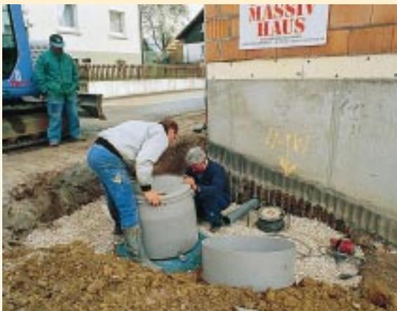
Die Grube wird nun beinahe bis zum oberen Rand des Regenspeichers ringsum mit Kies gefüllt. Danach wird der Domschacht bei Bedarf auf die erforderliche Höhe angepaßt und fest mit dem Regenwasserspeicher verschraubt
