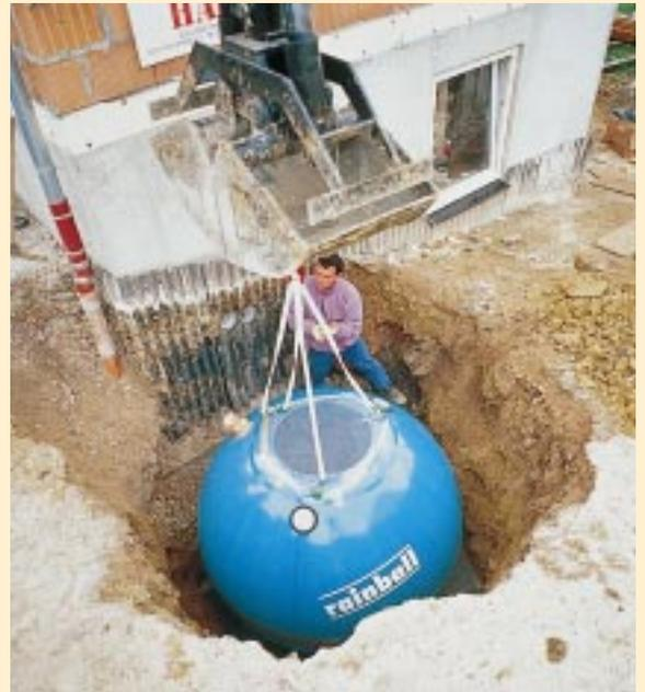
Beim Einsetzen in die Grube muß darauf geachtet werden, daß der Tank richtig ausgerichtet wird. Der Abstand zwischen Speicher und Grubenwand sollte ringsum etwa 30 Zentimeter betragen
