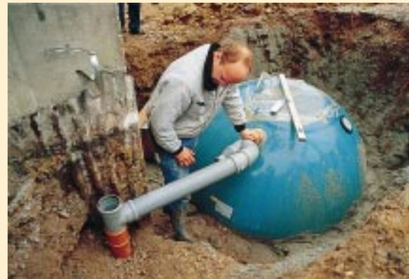
Der beruhigte Zulauf kann jetzt leicht angeschlossen werden. Dazu steckt der Installateur das Anschlußrohr in die vorgesehene Öffnung und verbindet es später mit dem Regenwasserzulauf
